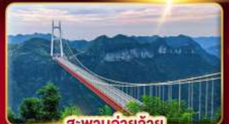
สะพานอ้ายจ้าย
